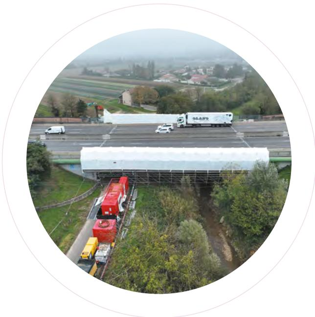
**TRAVAUX DE RÉFÉCTION DE LA PROTECTION ANTI-CORROSION DE QUATRE OUVRAGES D'ART SUR L'AUTOROUTE A7**
